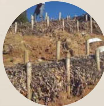
7. Muros estructurantes de contención y revestimiento que pueden ocupar gaviones, que pueden emplear geomallas o geotextiles.
