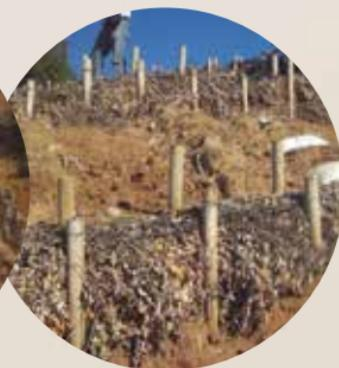
Realice trabajos de estabilización de pendientes y control de erosión y sedimentos, simultáneamente al inicio de la construcción de caminos, lo que incluye implementación de sistemas de drenaje.
